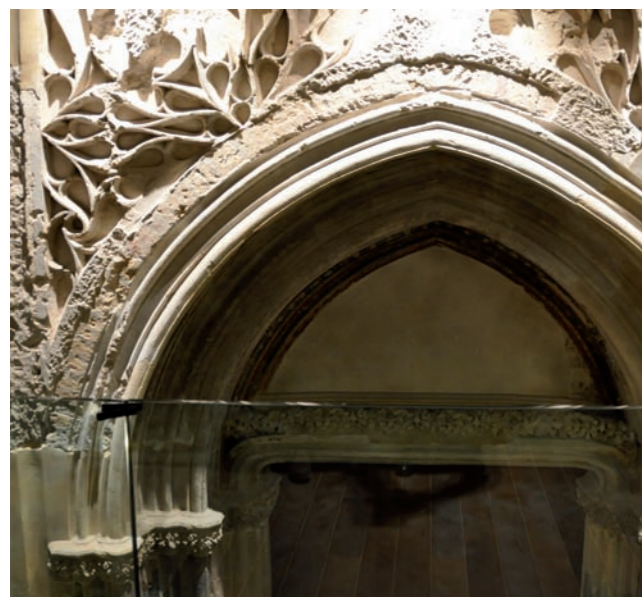
Acceso a la Capilla de don Hernando de Aragón, siglo XVI.
