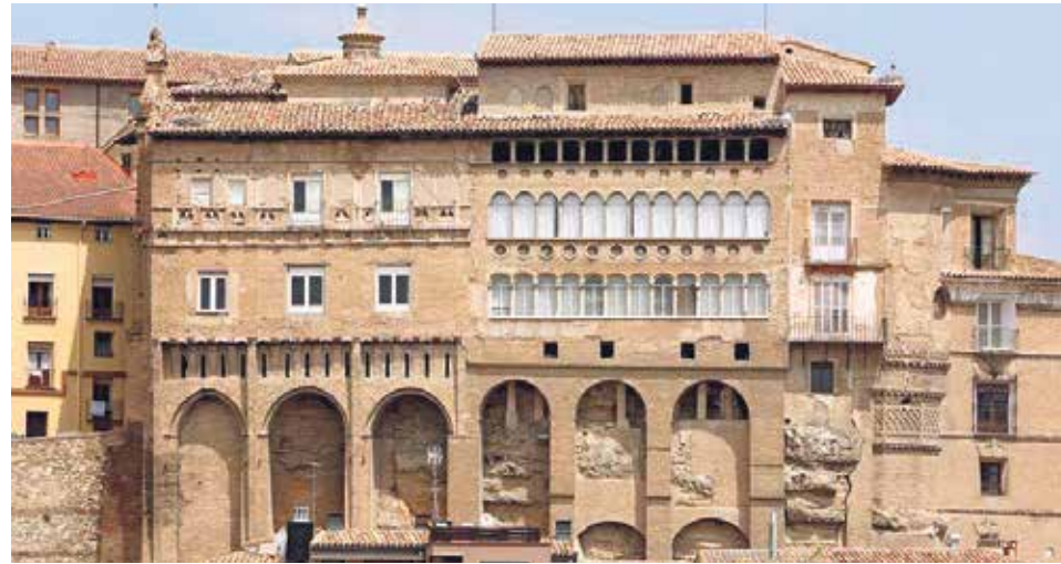
Vista del palacio episcopal de Tarazona.
